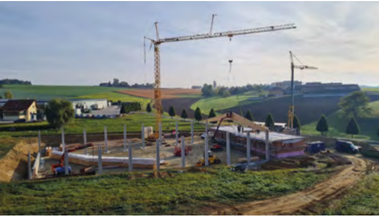
Die neue Reithalle entsteht
